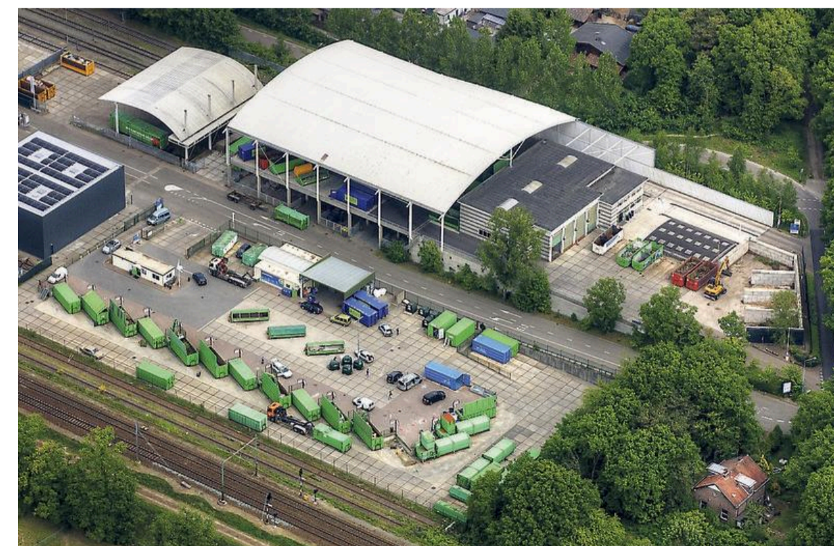
Het scheidingsstation van de GAD in Hilversum.
